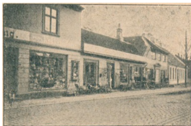
E. J. Rosleff's Isenkramforretning.
