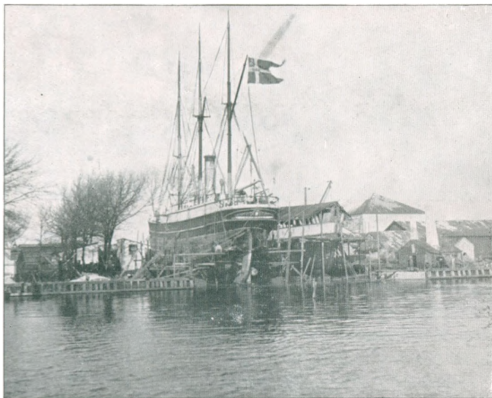
Fra R. Møller's Skibsværft. Et Fyrskib paa Bedding.
