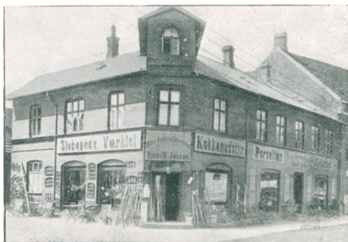
Viggo M. Jensens Isenkramforretning.
