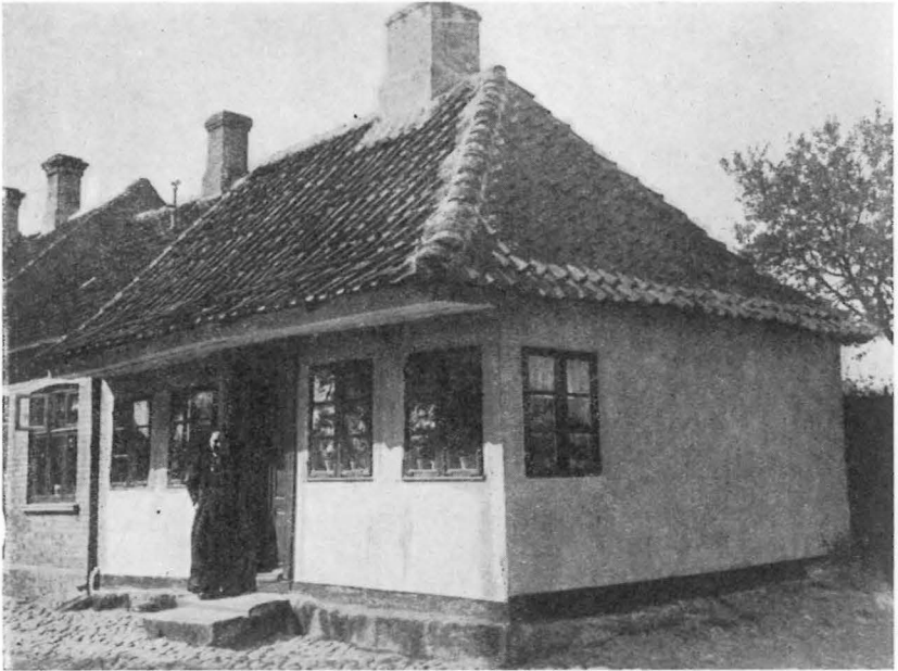
Den sidste Accisebod ved Munkebo Port
