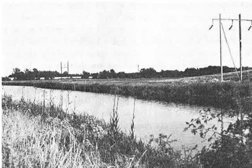
Omkring 1900 gravedes en ny kanal fra Nisted til Stige. Et stykke af den oprindelige kanal er endnu bevaret
