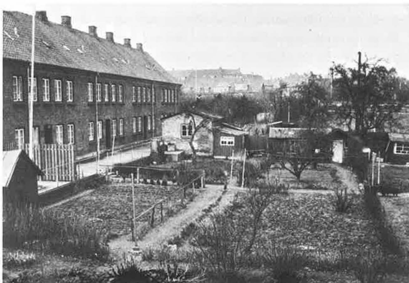
Ridehusgade 65. (Fot. 1978). På det nederste billede ses bygningen bagfra med nogle haver, der var til-lagt lejlighederne.
