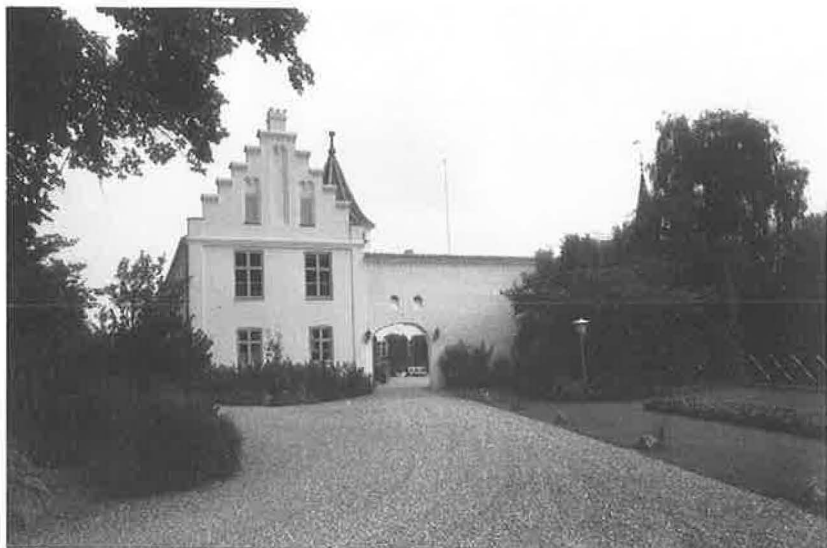
Spærremur og nordfløj set fra vest. Spærremuren er forsynet med skoldehuller over porten.
