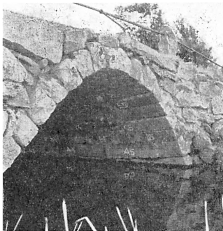
Povlsbro, vestsiden for ombygningen. foto Aaman Sørensen.
