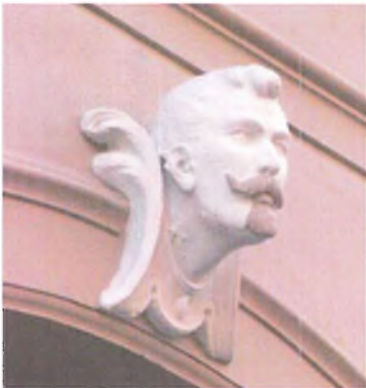
Ægirsgade nr. 44, udsmykning over dørportalen. Man ser, at facaden var pæn.
