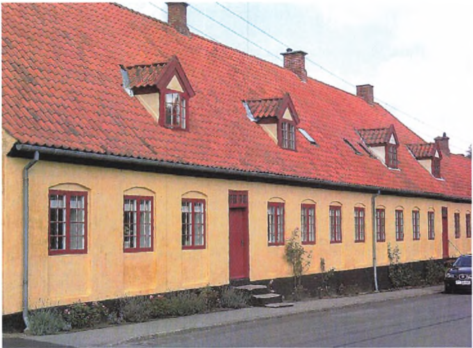
Bøssemagergades arbejderboliger fra Schimmelmans tid.
