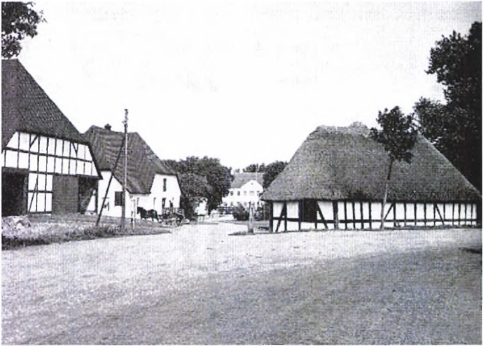
Scheelenborg hovedbygning, avlsgård og udlænger.
