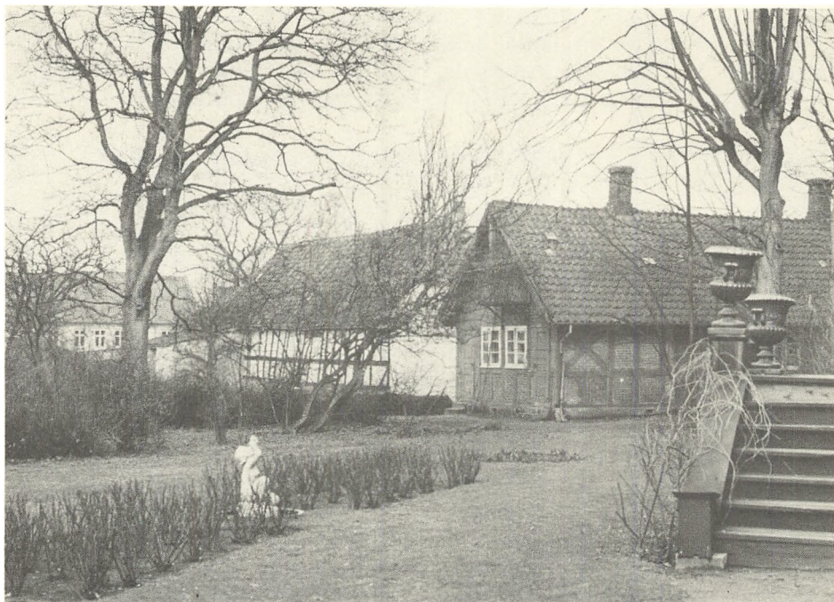
Fig. 3. Bindingsværks-havehus (gartnerbolig) i røde sten og præstegårdslade, ligeledes i bindingsværk, men ellers gulkalket. I forgrunden rosenbed og haveskulptur.
