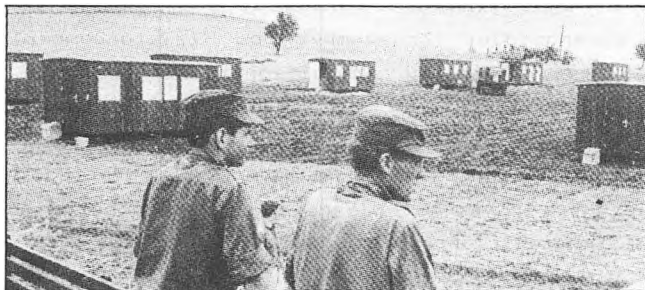
Ingeniørsoldater bygger huse i Jugoslavien.
