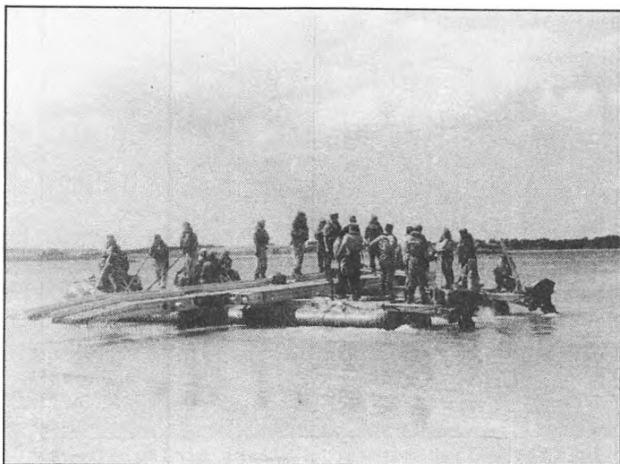
Færgen under bygning af materiel fra Feltbro M/62. Færgen har 2 Ewinrude-motorer med fjernstyring (Schlauch- boot-brücke).
