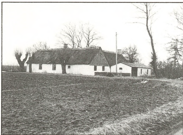
Eldre brug fra udskiftningstiden i husmandsbebyggelse nord for Asmindrup. Kalkning dækker som oprindeligt både tømmer og tavl, uden tjeret bindingsværk.
