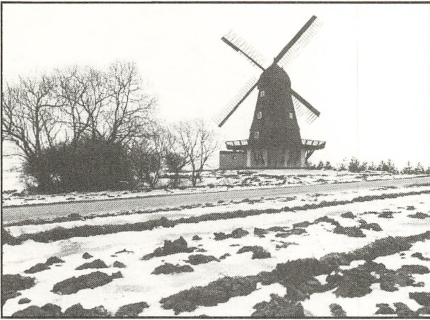
Kanehøj Mølle - en af de få eksisterende spåntækkede vindmøller, som endnu er tilbage i Sydvestsjælland. Byggestil og -måde rækker langt tilbage.
