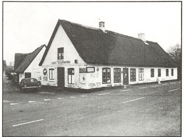
Øde Førslev, firlænget købmandsgård i overhvidtet bindingsværk med muret gavl. Med næringsfriheden (1862) kunne købmandshandeler oprettes på landet.
