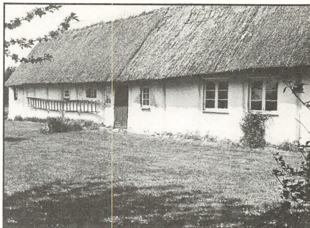
Husmandssted ved Eskilstrup i Odsherredsbindingværk, helt overhvidtet. Det vandrette tømmer mellem stolperne findes indvendig, så lervæggene buler ud.
