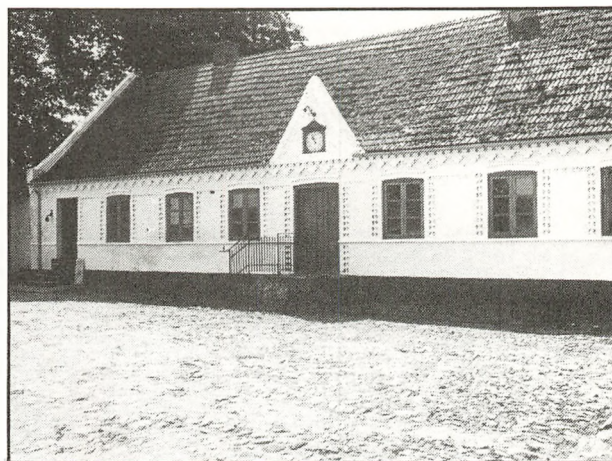
Gundestrup, grundmuret gård fra 1869, kornsalgsperioden. Med nyklassicistiske træk som "tandsnits"gesims lige under taget, og trekantanten over døren.
