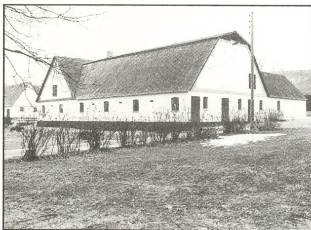
Grundmuret gård i landsbyen Kagstrup. Udlængerne har mansardtag, et iøjnefaldende karakteristika for Ringsted-egnens bygningskultur efter 1900.
