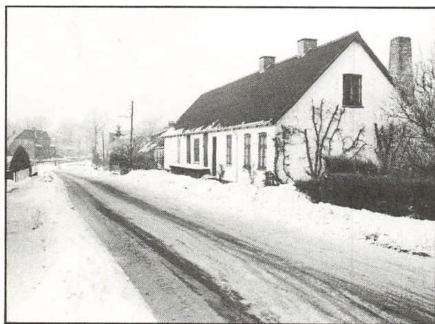
Nedlagt andelsmejeri i Flakkebjerg. Eksempel på grundmuret servicefunktionsbygning fra andelstidens begyndelse, meget lig tidens andre funktionsbygninger.
