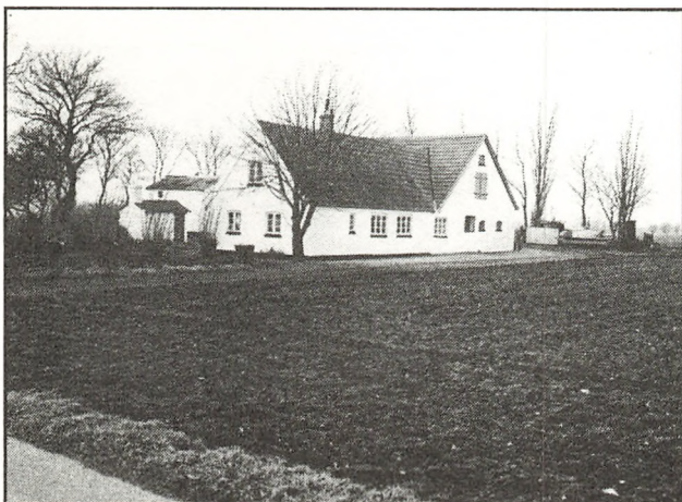
Statshusmandsbrug i kolonien ved Melby Sønderstrand. Hvidkalket vinkelbygning med cementstenstag opført i Bedre Byggeskik-stil i 1920'erne.
