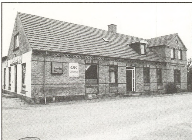
Havrebjerg brugsforening, bygget omkring 1900 i gule mursten med rødstensdekorationer. Med bolig til brugsuddeleren, og lager i sidefløjen.
