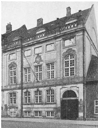
Hus i »Frederiksstaden«, Amaliegade 17, opført 1754-56 for stenhuggermester J. P. Pfeiffer efter tegning af Nicolai Eigved.
