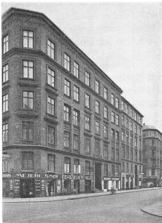
Københavnske lejehuse fra slutningen af 19. årh. efterlignende italiensk renæssancestil. Det nærmeste hus er prydet med ornamenter i murstensrelief. St. Hans Gade på Nørrebro.
