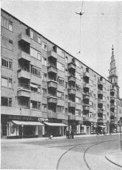
Moderne boligbyggeri i Prinsessegade på Christianshavn. Eksempel på bygning med de udvendigt anbragte altaner, der var almindelige i 1930'erne.
