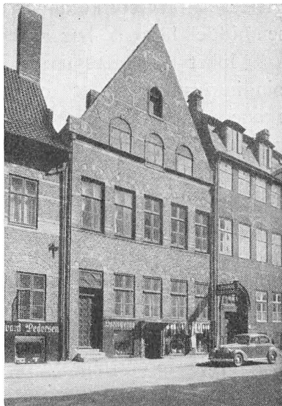
Københavnsk stenhus fra renæssancetiden. Strandgade 28, opført i 1620'erne. Dette gavlhuis er blevet en del forandret af eftertiden; et pudslag har dækket den røde teglstensmur, og gavlens svejfedede profileringer, der har fortsat sandstensforsiringerne på lignende måde, som det ses på gavlen af Rosenborg, er blevet fjernede. Først i 1943 er bygningen blevet bragt så nært som muligt tilbage til den oprindelige skikkelse.
