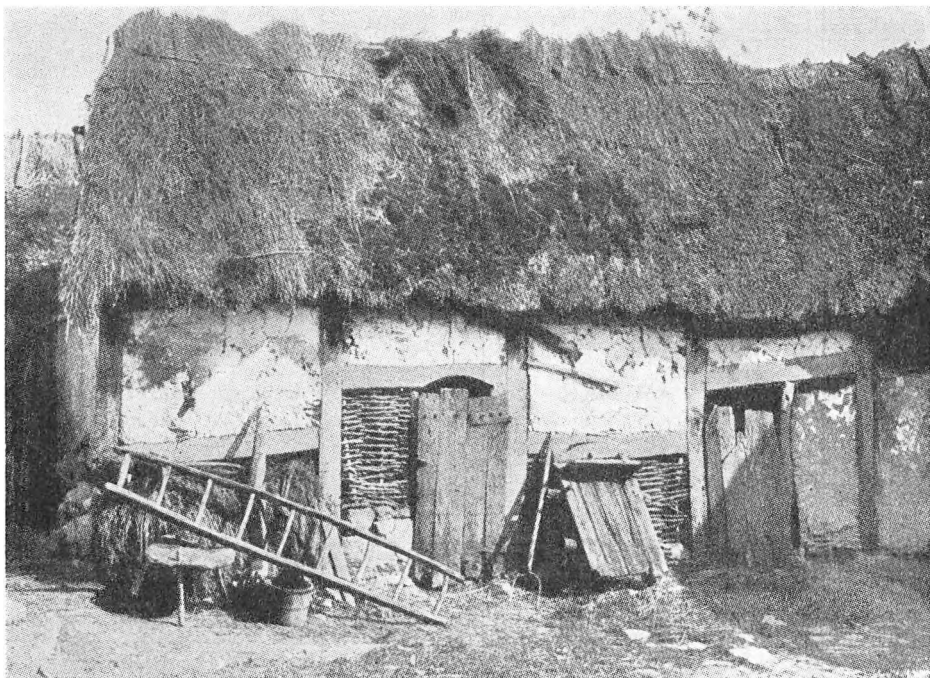
Gammelt udhus ved en midtsjællandsk bondegård. Bindingsværk med stolper anbragt på syldsten og med lerklinede tavl på flettede vidjer, det såkaldte »vendreværk«.
