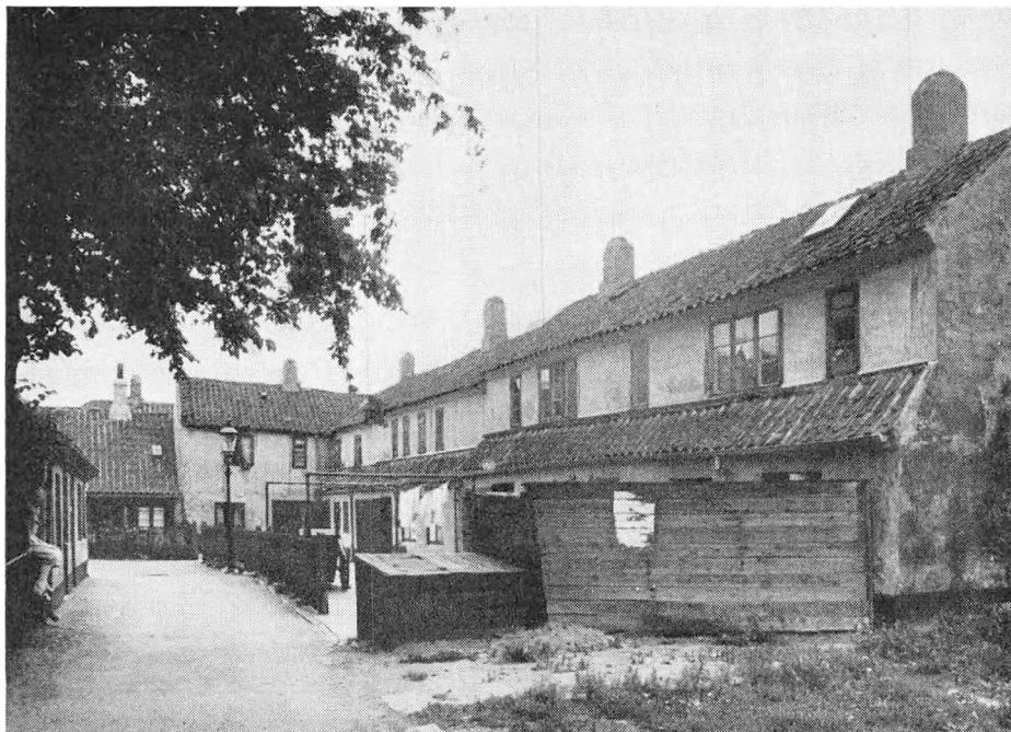
»Boder« i Sundbyøster på Amager, bygget i begyndelsen af 19. årh. i Minorokagade. En ekstra etage er føjet til de oprindeligt enetages huse.
