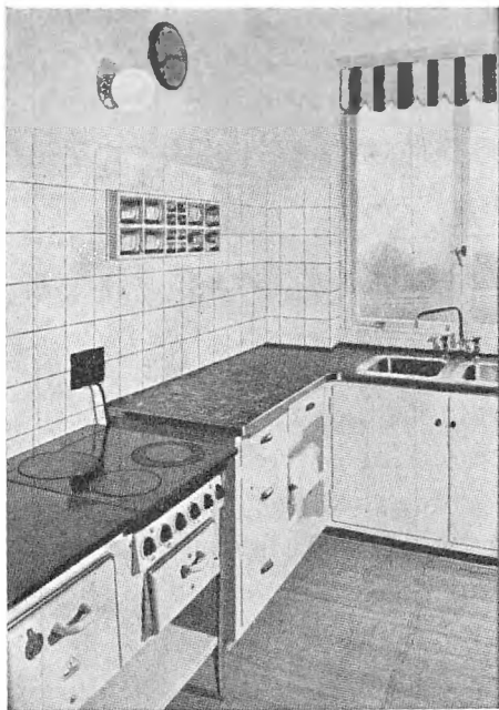
Det moderne køkken fra 1940'erne. Der er flisebeklædning på væggene, vask af rustfrit stål, elektrisk komfur og bageovn, elektrisk ur m. m. Arkitekt: Eske Kristensen.
