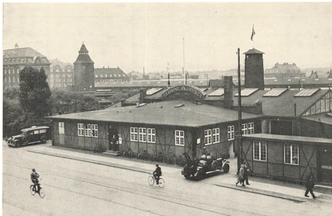
Falcks Redningskorps Hovedstation i København, Tietgensgade 67—69. Bag de lave Bygninger med Kontorer, Vagtstuer etc. ligger den store Garage. Bagerst ses Slangetaarnet, i hvilket Brandslanger hænges til Tørring efter Brugen.
