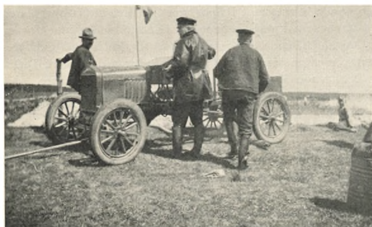
Falcks Brandvagt i Sønder Felding er moderne nok til at bruge Skumslukning.
