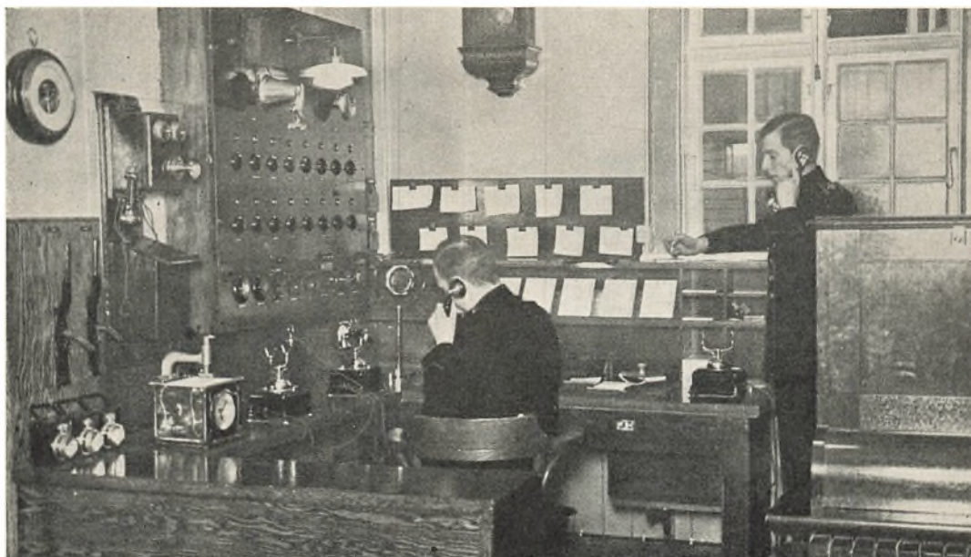
Vagtstuen paa Hovedstationen i København, før Korpset fik eget Omstillingsbord. Vagtmesteren tager mod en Melding. Foran ham Mikrofonen, fra hvilken han gennem Højtaleranlægget alarmerer Mandskabet overalt paa Stationens Grund.
