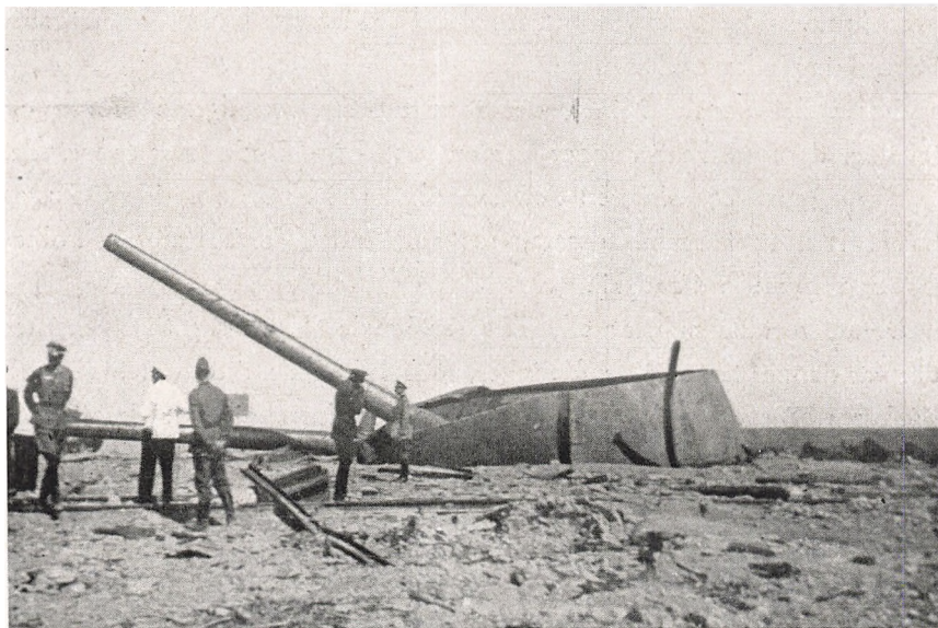
Sønderskudt Pansertaarn med 2 Stk. 30 cm Kanoner. Det ene Kanonrør er sprængt ud af Affutagen, paa det andet ses Mærker af Sprængstykker. Det russiske Fort Maxim Gorki I Nord for Sewastopol.
