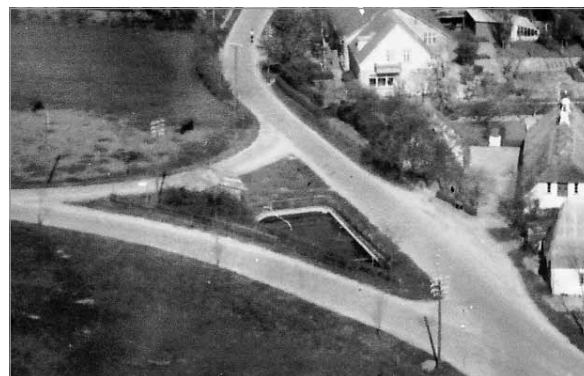
Branddam og brandstation med brandsprøjte
