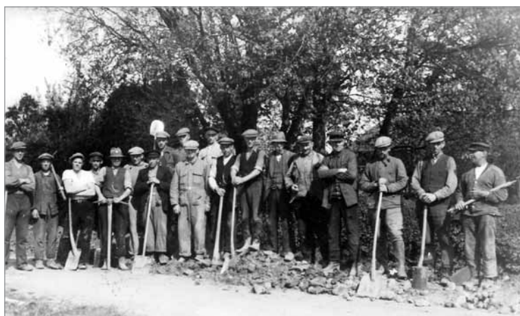
Arbejdshold der graver vandleddning ned på Kær Bygade
