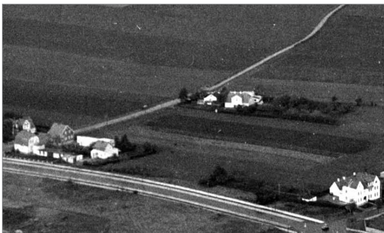
Lysmose i midten ved Kærvej
