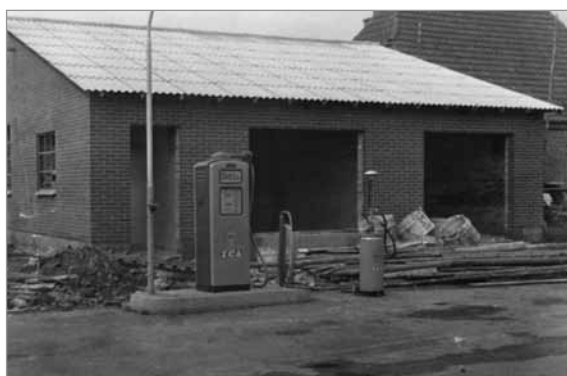
Shell tank med begyndelsen til nyt værksted
