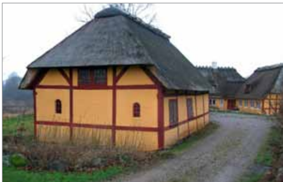
Den renoverede lade
