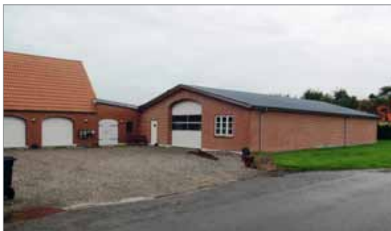
Nyt maskinhus fra 2015
