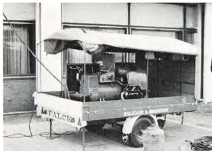
Enhed 8016 var i drift i 11 timer i lufthavnen, hvor man måtte udlægge 600 meter kabel.
