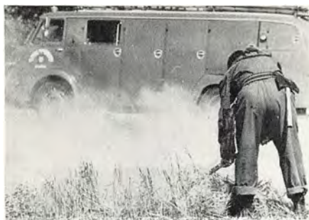
Nyborg-stationen på brandslukning.
