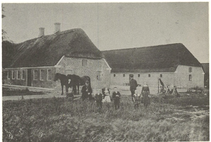
I.'s gård "Stavskærgård"
