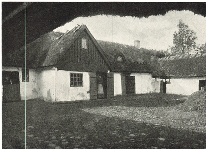
Udbygning paa Gaardsiden af en Stuelænge i Faarevejle, Ods Herred.
