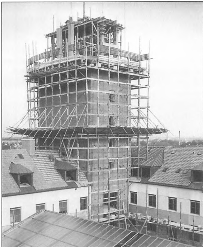
Tårnet rejser sig langsomt mod himlen. Situationen er taget fra tværføljen i sommeren 1951 hen over den glasoverdækkede rådhushal og øst- og nordfløjene (Frederiksberg Stadsarkiv).
