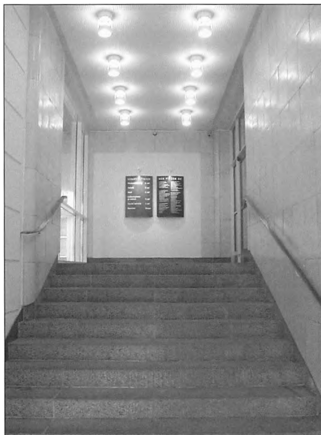
Trappen bag den nye Vestindgang med skiltning for servicebutikker og øvrige kontorer i hver sin farve. (Arkitekt- og ingeniøraftdelingen, Frederiksberg Kommune)
