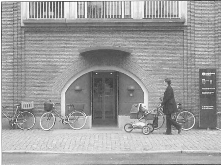
Den nye handicapvenlige indgang fra Frederiksberg Bredgade 4 til person- og vareelevator. (Arkitekt- og ingeniøraftdelingen, Frederiksberg Kommune)
