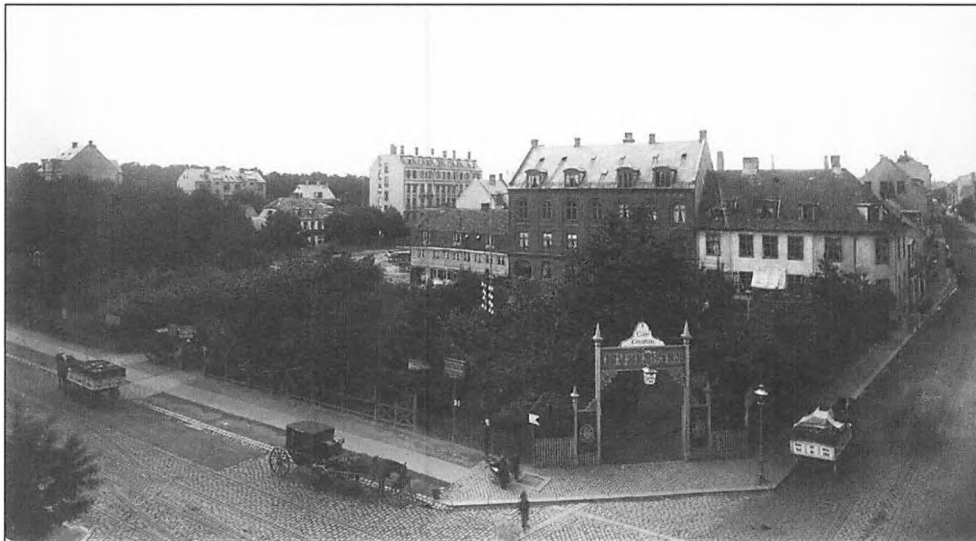
Allégade mellem Bredegade og Smallegade fotograferet 1895. Hjørnebygningen ved Bredegade, nr. 31 er netop nedrevet. Tilbage står nr. 33, kaldet "Den hvide Svane" (et af de steder bystyret havde holdt til), den høje nr. 35 fra 1867 og hjørnehuset ved Smallegade, nr. 37, slotsgartner Peter Petersens tidligere ejendom. (Frederiksberg Hovedbibliotek, Lokalhistorisk Billedsamling).
