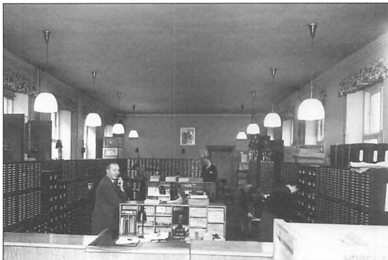
Travlhed på Installationskonto- ret i Den tekniske Forvaltnings admi- nistrationsbygning på Mynstervej 5 få dage før indflyt- ningen til det nye rådhus i foråret 1953. (Frederiksberg Stadsarkiv).
