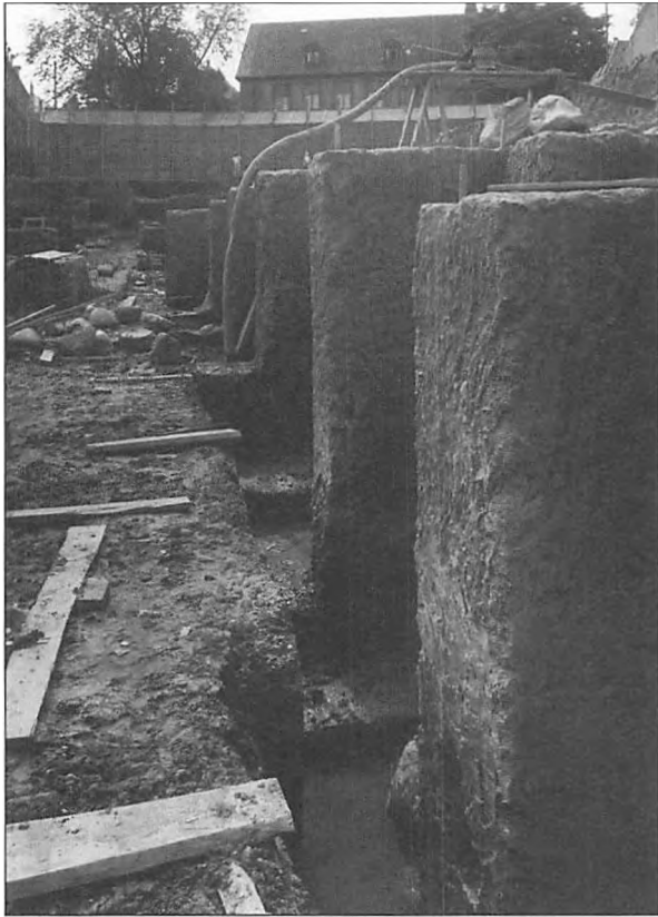
Byggepladsen i sensommern 1942. Udgravningen til kældre og fundament er i fuld gang i vestfløjen ud for Frederiksberg Bredgade 11, der i 1949 blev indrettet til kontorer for Folkeregisteret og dermed var den sidste af de mange bygninger rundt om i byen, hvor forvaltningen havde kontorer før rådhusets endelige indvielse i '53. Bygningen blev i 1970'erne ingen inddraget som rådhusanneks (Frederiksberg Stadsarkiv).
