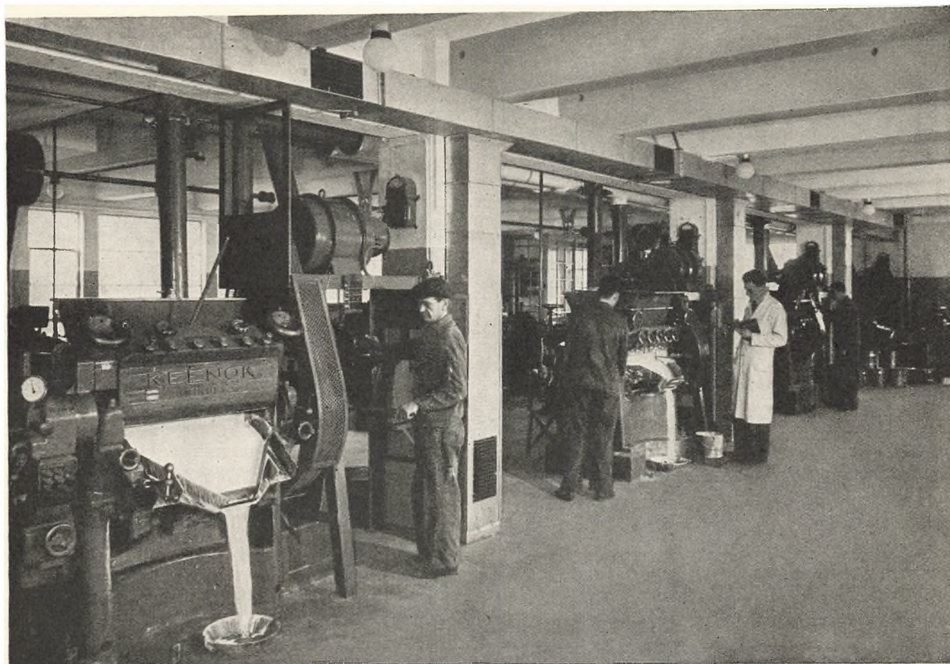
Sal med Rivemaskiner. Gennem lodrette Rør fra Etagen ovenover løber den færdigblandede Farve direkte ned i Maskinerne, hvor Pigmentet findeles i Bindemidlet, saa man faar en jævn Maling. Gennem Gulvet ledes Farven videre til Toning i næste Etage.
