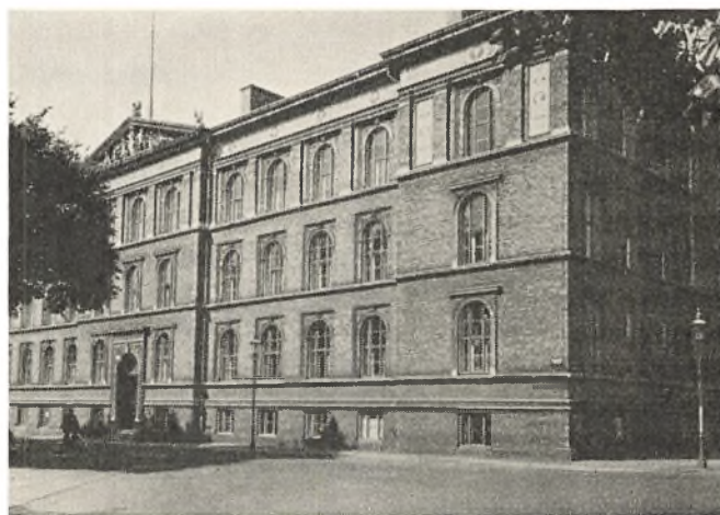
Det tekniske Selskabs Skole i Ahlefeldtsgade.
