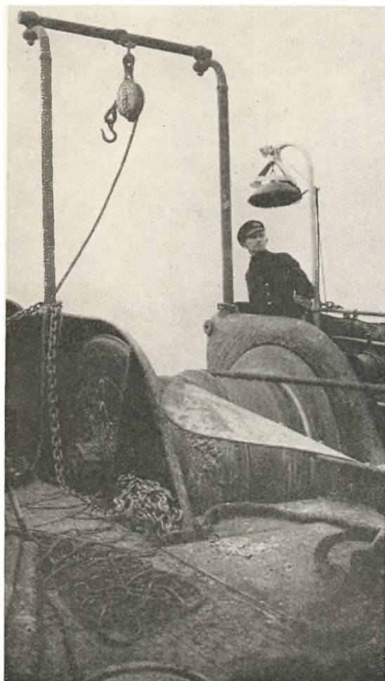
Udlægning fra en Kabeldamper.
