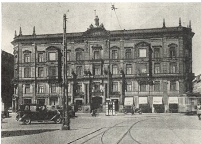
Store Nordiskes Bygning i København.
