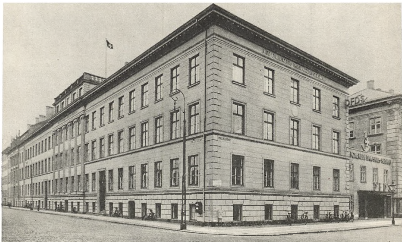
Administrationsbygningen i Kvæsthusgade. Grundstenen lagt i 1684 til det oprindelige Formaal: Søgæsthuset.
