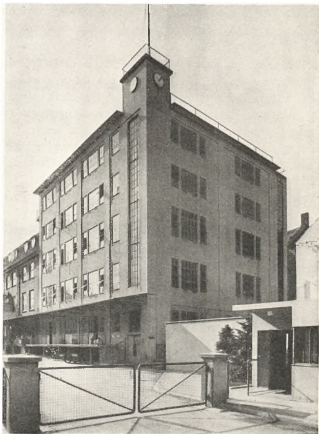
Indkørslen til Sadolin & Holmblads Fabriksanlæg paa Amager med Malerverefabrikken, hvor Produktionen ledes fra øverste Etage nedefter for at ende i Lagerkældrene.
