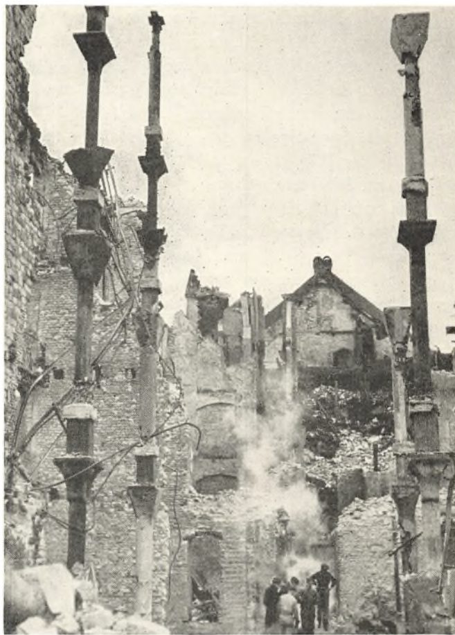
Luftværnets Folk paa Oprydningsarbejde i Knippelsbrogade.
