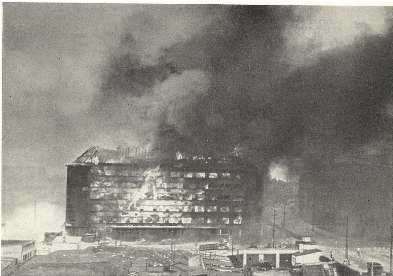
Shellhuset under Branden efter de engelske Luftangreb.
