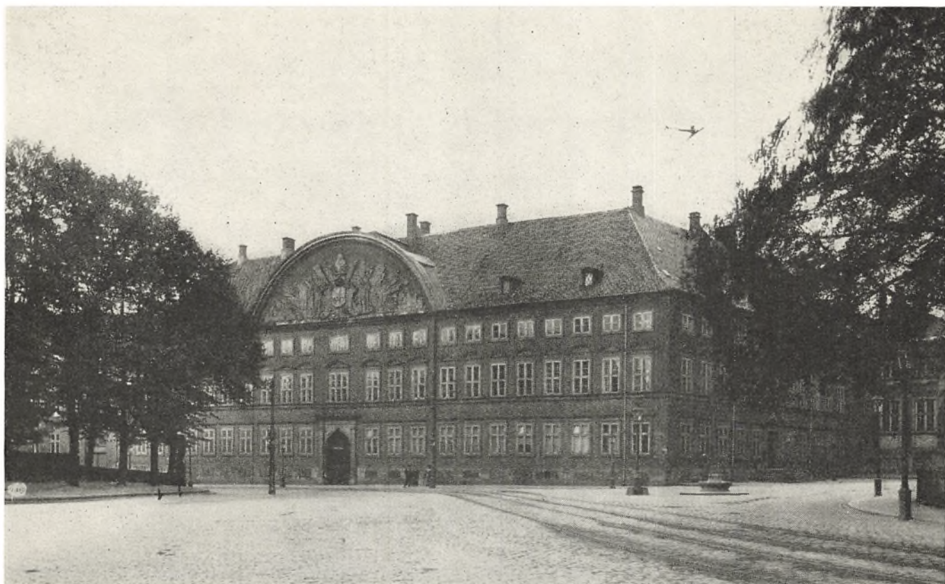
»Den røde Bygning« i Slotsholmsgade.
