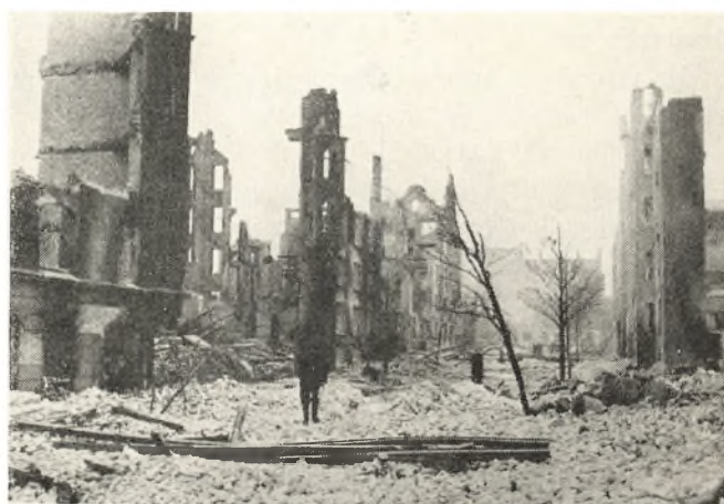
Bombeskaden paa Maglekildevej.
