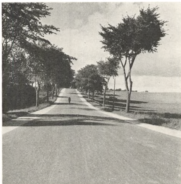
Landevej med ru Belægning indfattet af lys Dammannasfalt. Fremstillet af Aktieselskabet Dansk Dammann Asfalt.
