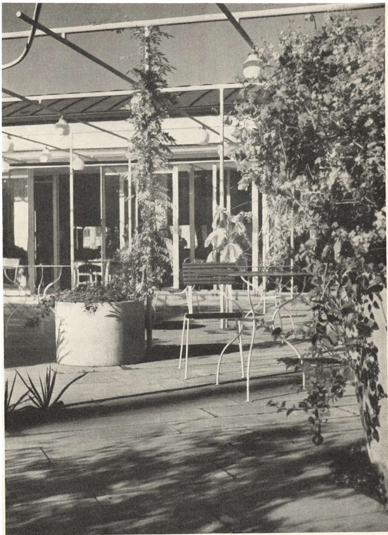
Taghave uden for Marketenderiet, planlagt af G. N. Brandt. Jordlaget er 10—35 cm tykt. Større Vækster er plantet i Betonringe.
