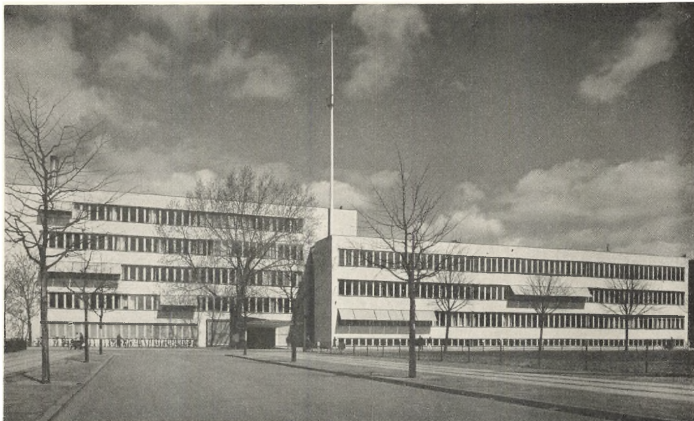
Radiofonihusets Kontorbygning. Façade mod Rosenørns Allé.
