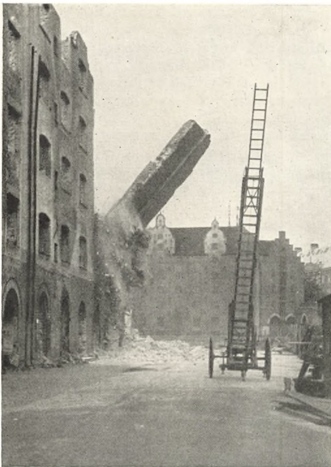
Murnedrivning ved Ejendommen i Knippelsbrogade.
