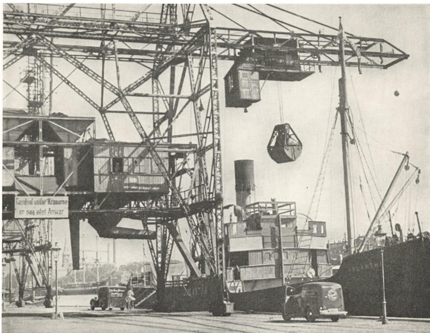
Kulkranen i Arbejde ved Kalvebod Brygge.
