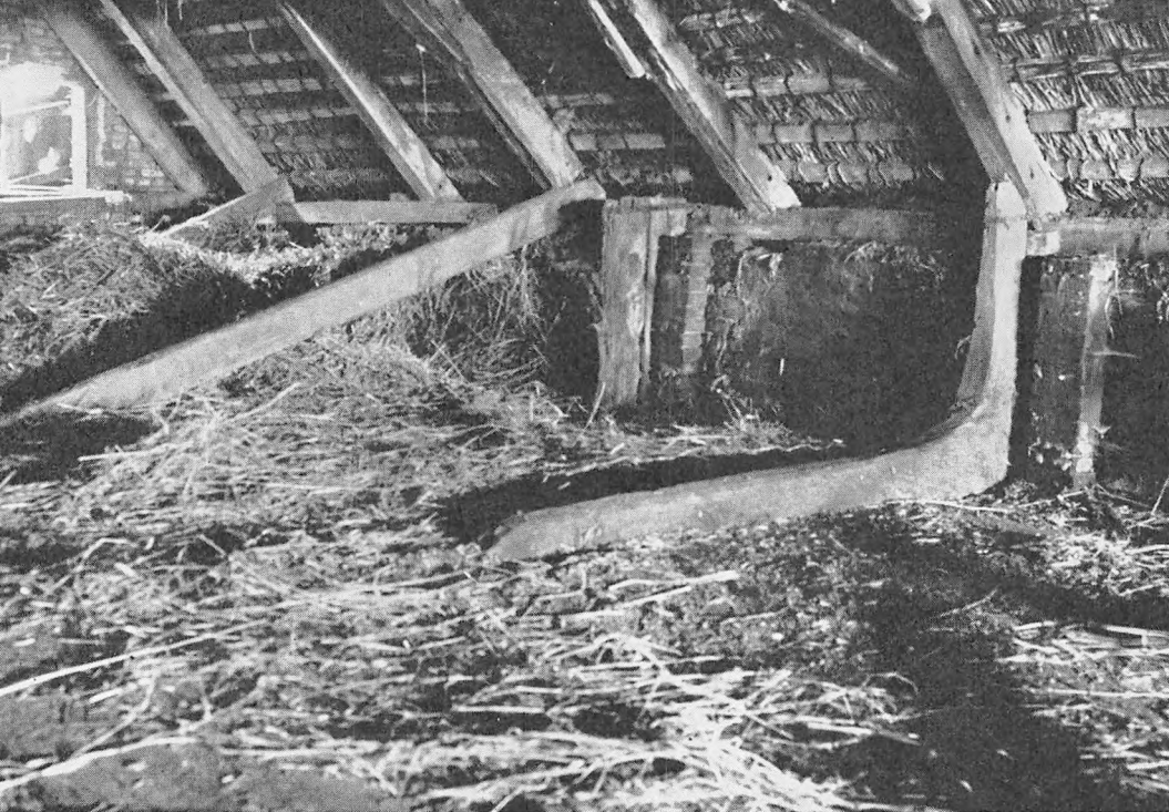
Fig. 30. Spante anvendt i tagkonstruktionen over staldloftet. (Kai Uldall fot. 1939).
