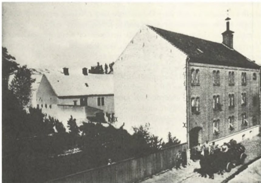
Bryggeriet Carlsminde efter moderniseringen i 1887, hvor der blev bygget nyt bryghus, malteri samt kedel- og maskinhus. I forgrunden holder ølvognen og i baggrunden skimtes trækionerne fra Kronprinsens Bastion. Foto på 1/5 Bryggeriet Carlsminde.
