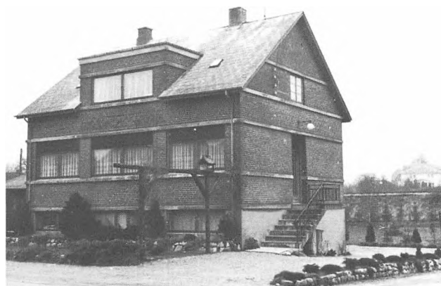
Teknisk skoles tidligere bygninger i Assens og Ebberup. Sidstnævnte er nu beboelse, mens skolebygningen i Assens er overtaget af Vestfyns Handelsskole.
