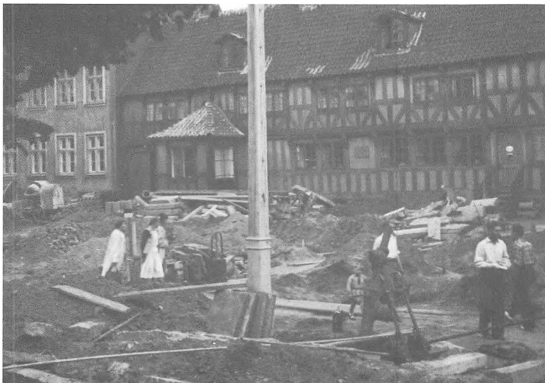
Ikke skyttegravskrig, men kloakarbejdet foran Willemoesgården 1950
