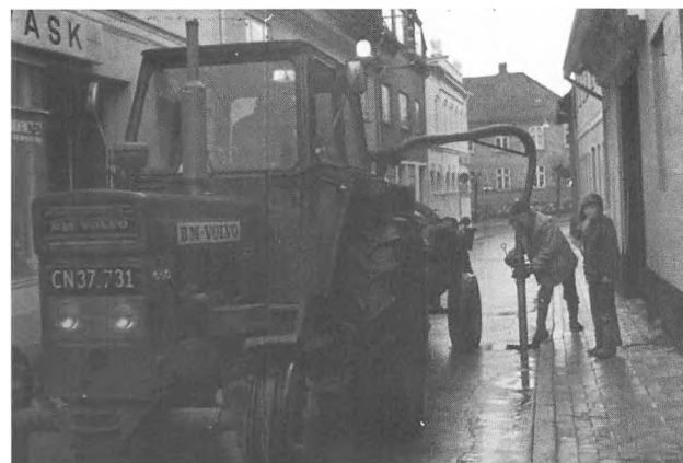
Renning af kloakker foretages med en slamsuger
