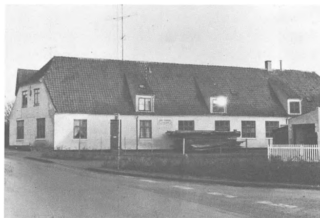
Stokkefabrikken på Skelvej
