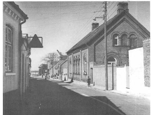
Tidl. logebygning i Havnegade
