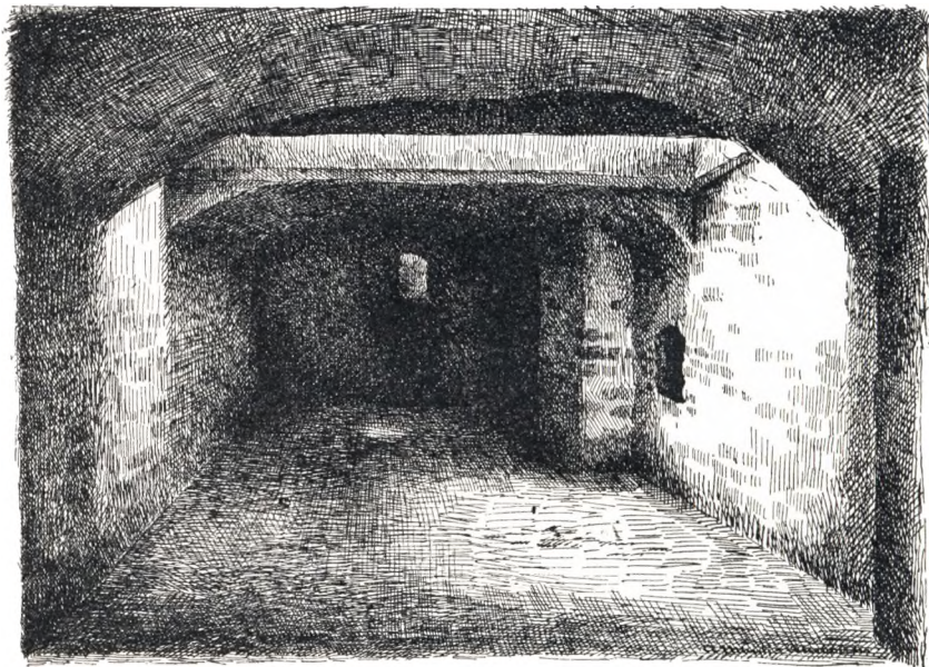
Det ene af de to hvælvede KÆLDERRUM under det nuværende Ligkapel; en Lem i Gulvet er aabnet for at skaffe Lys derned. (Tegn. af Ax. Munk-Andersen.)
