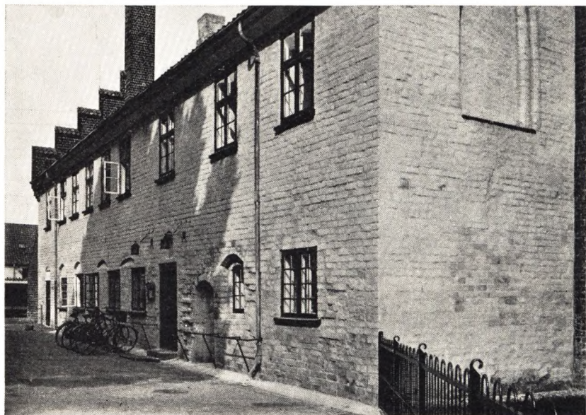
KLOSTERETS VESTFLØJ efter den sidste Istandsættelse 1936. I Gavlen det tilmurede store Vindue, over Stueetagens nyere Vinduer ses Spor af de oprindelige; til højre for Døren en Fortanding i Muren, her har formodentlig en Ringmur været tilsluttet; ved Siden af ses en gammel Døraabning og et Vindue. (Fot. af Arch. Ange Roussell, Nationalm.)
