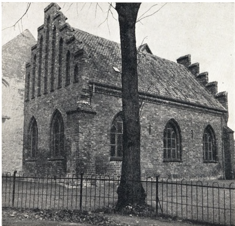
KAPELLETS NUVÆRENDE YDRE. De pyntelige gotiske Gavle fra 1863 er Arkitektens, Chr. Hansens, fri Opfindelse; i Vestgavlen sad til da paa Blændingernes Plads Resterne af de to store Vinduer i 2. Stokværk. -- Til venstre ses lidt af Klosterets Vestfløj. (Döcker Smith fot. 1936.)
