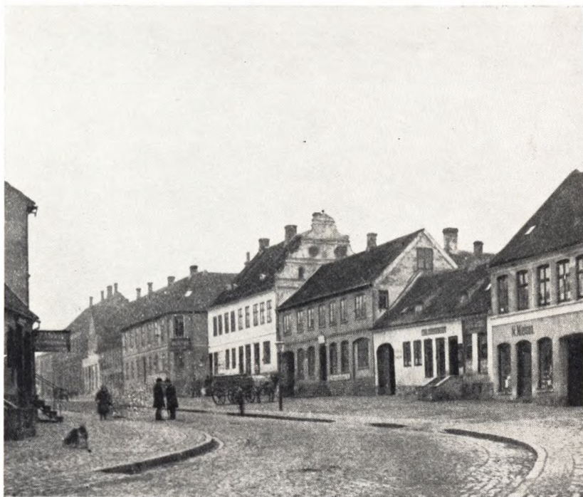
Midt i Billedet ses den endnu bevarede Vestgavl af den store Renaissance-Gaard fra ca. 1600, den senere Amtsskrivergaard, hvis Hovedbygning blev gennembrudt, da Nygade ca. 1850 førtes op gennem Gaardspladsen og Haven. (Fot. fra Slutn. af forr. Aarh.).
