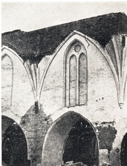
FRA KIRKENS INDRE, Fotografi taget under Nedrivningen. Man ser rester af de smukke Hvælvinger fra den ældste Kirke og et af dens høje Vinduer, som blev muret til, da Sideskibet opførtes og de gamle Ydermure gennembrødes af Arkadebuerne, som ses under Vinduet. (Fotografi paa Nationalm.)
