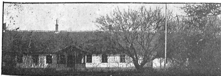
Stensgaards Hovedbygning set fra Haven.
