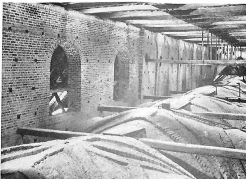
Muren over Hvælvingerne.
