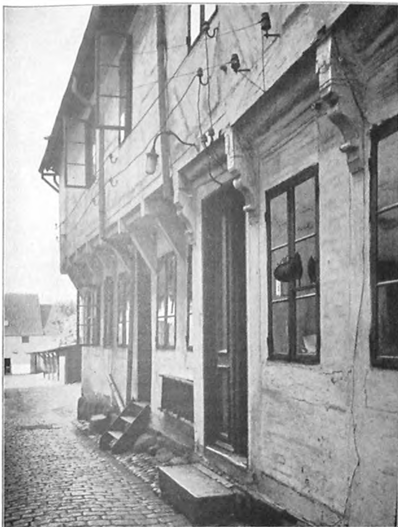
Sondergade 6, Jessens Gaard, der i det 17de Aarh. ejedes af Matz Bergen; det gamle Gavllhus' Østside set fra Porten til Gaden; Bjælkehovedknægtene ned mod Gaarden er meget enkle, de tre forreste derimod elegant svungne Konsoller; denne Form har Gade­façadens Knægte sikkert haft.
