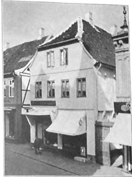
Gavl til Gaden og en Slippe paa hver Side. * Søndergade 25, et typisk Gavthus.
