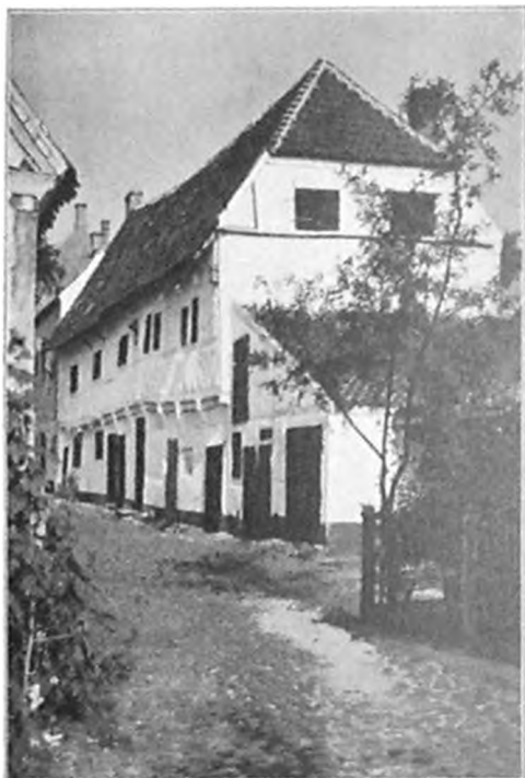
Pakhus fra det 17de Aarh. i Gaarden Søndergade Nr. 29. Strandstensbrolægning. Stokroser.*
