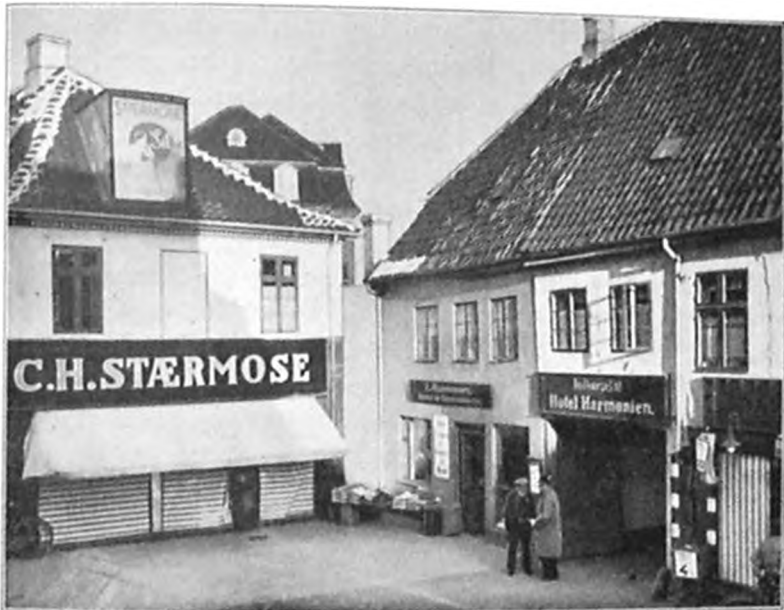
Søndergade, »Krogen« mellem Nr. 40, »Harmonien«s gamle Længe, og Nr. 42.
