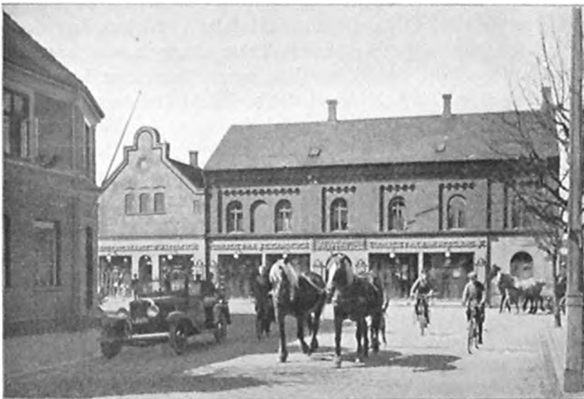
1935. Samme Sted. E. F. Dan opførte den nye Gaard 1875; Stueetagen blev helt ombygget, da P. Hatten & Co. købte Ejendommen 1921. *
