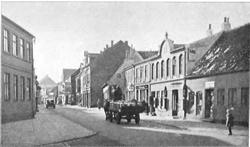
Samme Sted 1935. De ældgamle Huse er forsvundet; men i Façadelinjen findes endnu de mange Uregelmæssigheder, der synes at være ganske »byplanløse«.
