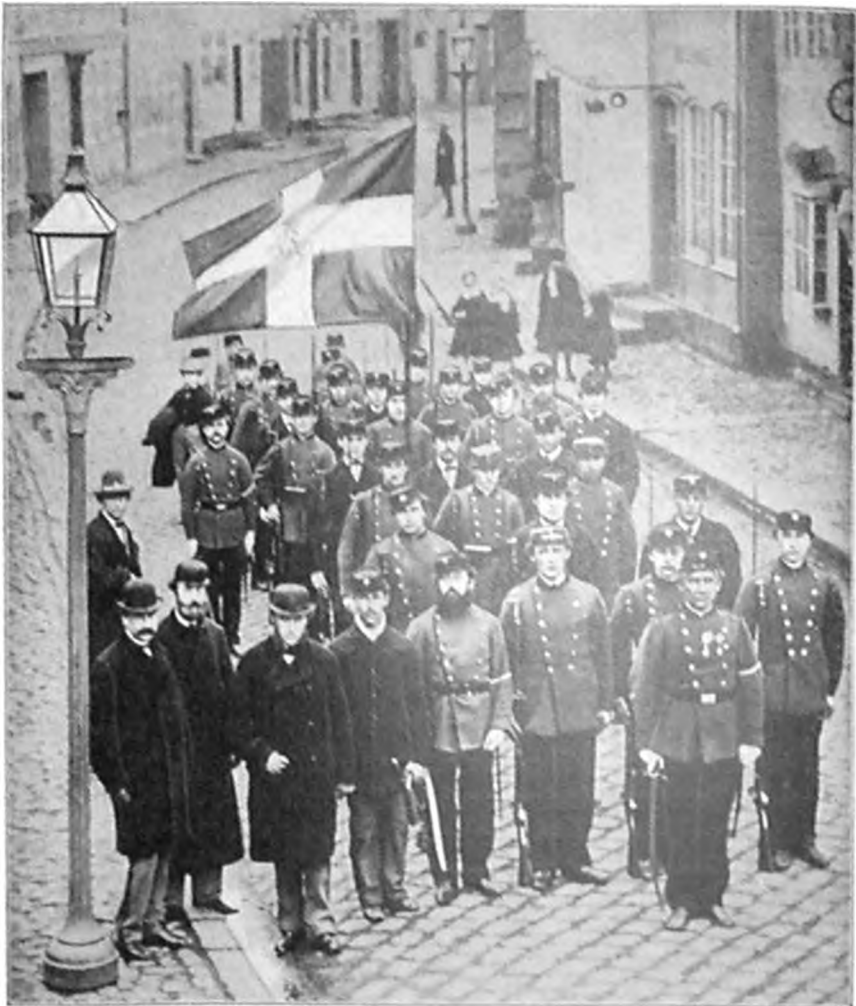
Politikorpset i 1860'erne, fotograferet af Ad. Lomborg fra hans Dagligstuevindue, Søndergade 42. Huset længst til højre, Nr. 47, tilhørte Drejer Ad. Clausen.
