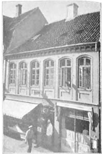
6. Søndergade 11. 7 11 1854. I Sal har typiske, tætstillede, høje Vinduer. I Stuen ses, ligesom i 7, Støbejernssprosser i Butiksvinduet, der dog er noget moderniseret.
