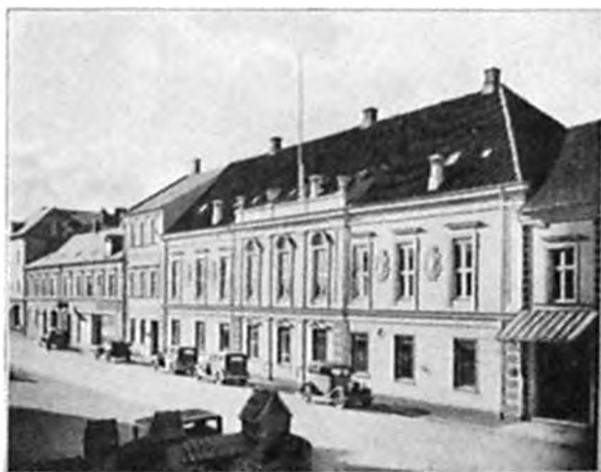
»Haandværker- og Industriforeningen«, Hotel »Harmonien«. Opført 1867. Det nuværende Udseende stammer fra Ombygninger ca. 1900.
