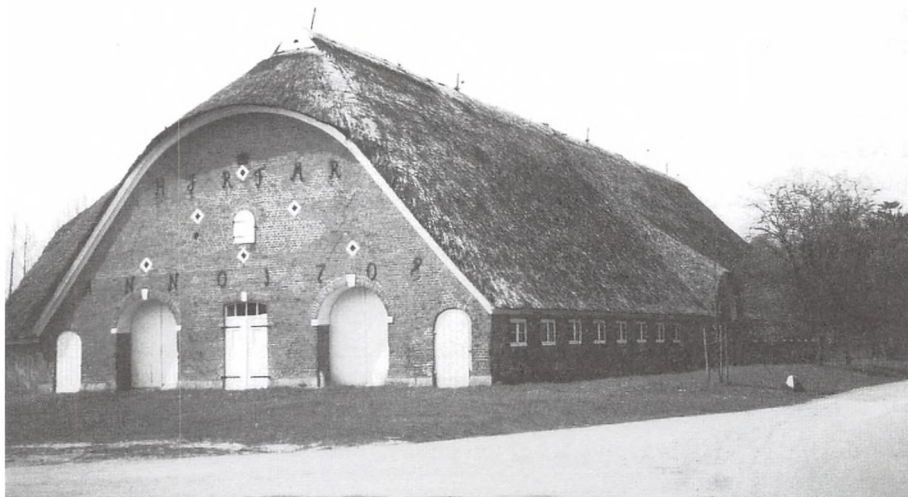
Kostald med lade (Kuhscheune) ved godset Bossee, beliggende i Kreis Rendsburg 19 km sydvest for Kiel ved Westensee. Bygningen er opført 1709 af ejeren på Westensee, Josias Rantzau. (Foto: Joachim Memmert).
