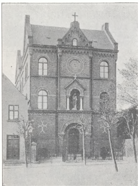
Det nye St. Josefs Hospital, opført 1885.
