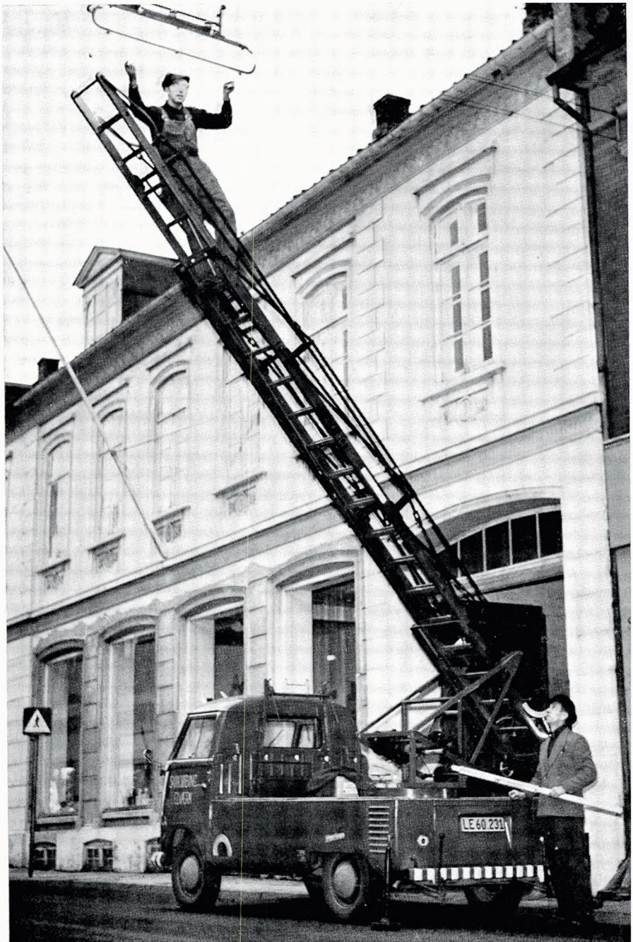
Stigevognen i arbejde med gadebelysningen På stigen: driftsassistent Kai Axelsen, ved vognen: elektriker Ingemann Petersen
