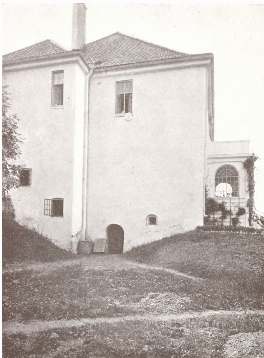
Den gamle del af hovedbygningen paa Sem, bygget over 2 svære hvælv.
