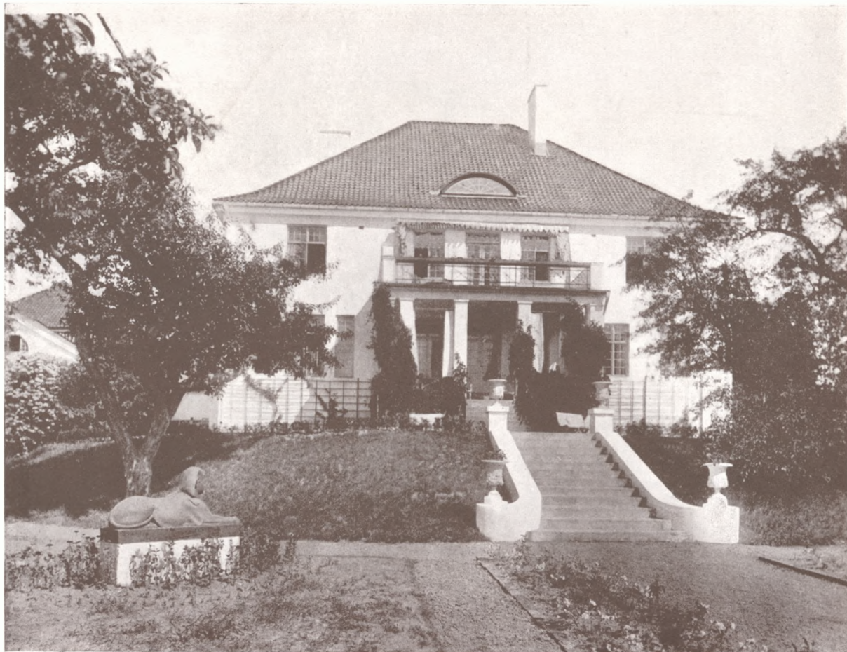
Sem. Façade mod haven og Borrevandet.
