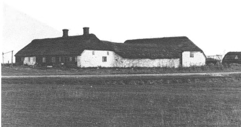
Ndr. Skottesgård, matr. nr. 14 (fot. ca. 1931 fra nordvest). Vestlængen er sammenbygget med stuehus og lade, men med åben port ind mod lade.
