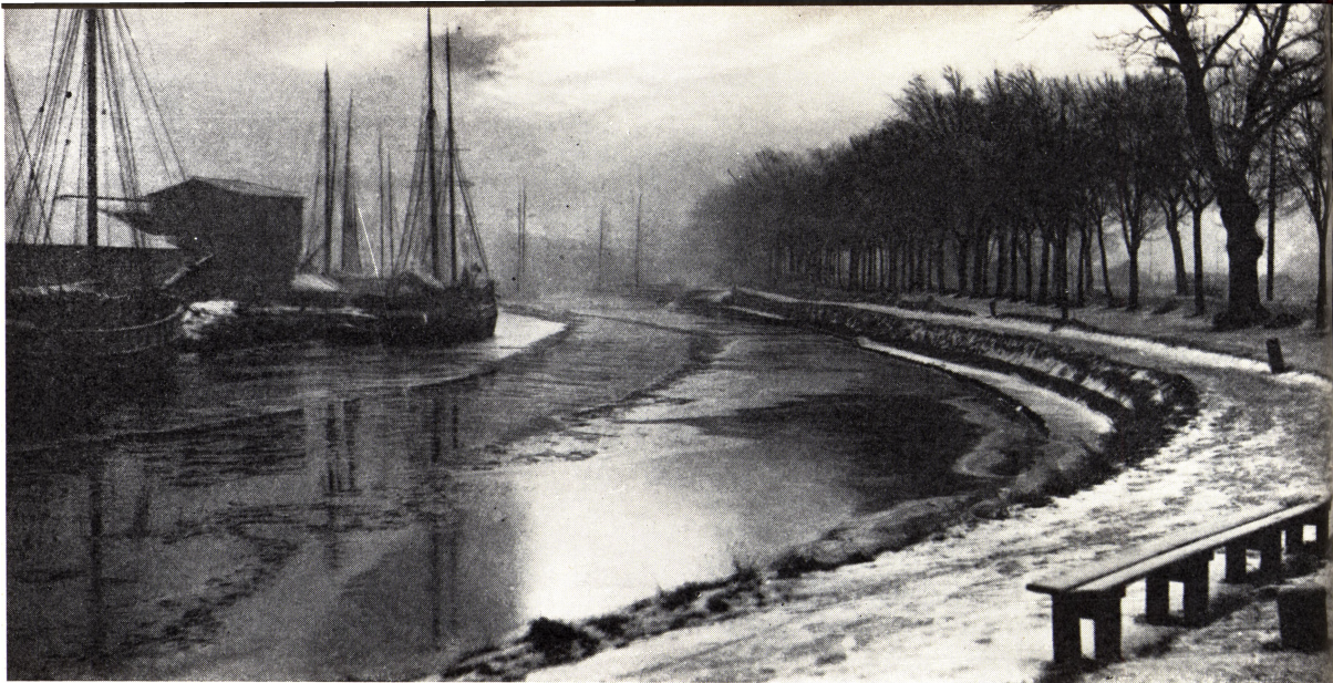
Udsigt fra Kanalvej mod tidligere gamle havnebassin
