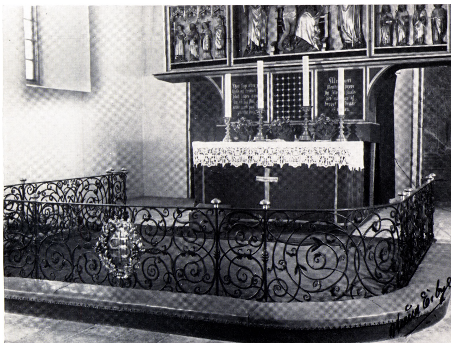
Smedejernsgitter. Østbirk Kirke ved Horsens, 1950. Skjoldet og Monogrammet er drevet op i Bronze, de 2 Vingrene med Druerne smedet i Bronze.
