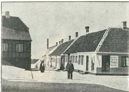
Martin Hansens Skotøjsforretning.
