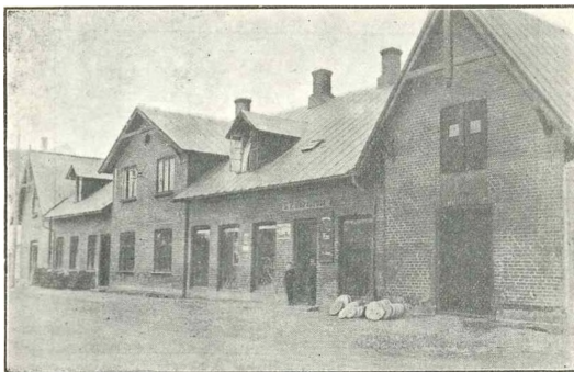
C. F. Gerstrøms Forretningsbygning.
