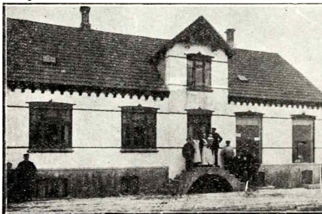
J. P. Petersens Møbelforretning.
