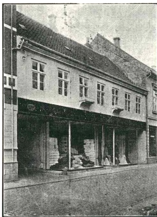
Ferd. Hahns Manufakturforretning efter sidste Ombygning 1917.
