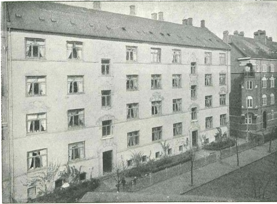
Postforeningen af 1872's Bygning, Mariendalsvej 38 og 40.
