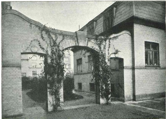
Pavillon og Forbindelsesmur ved Postforeningen af 1872's Bygning.
