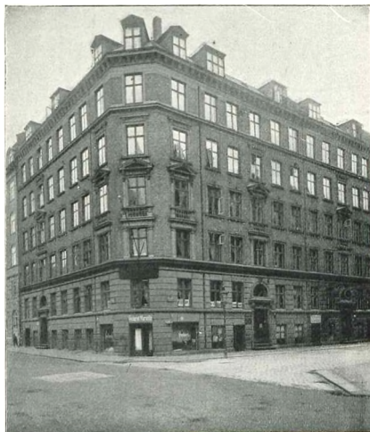
Postbudenes Byggeförenings Ejendom, Brorsonsgade 10.
