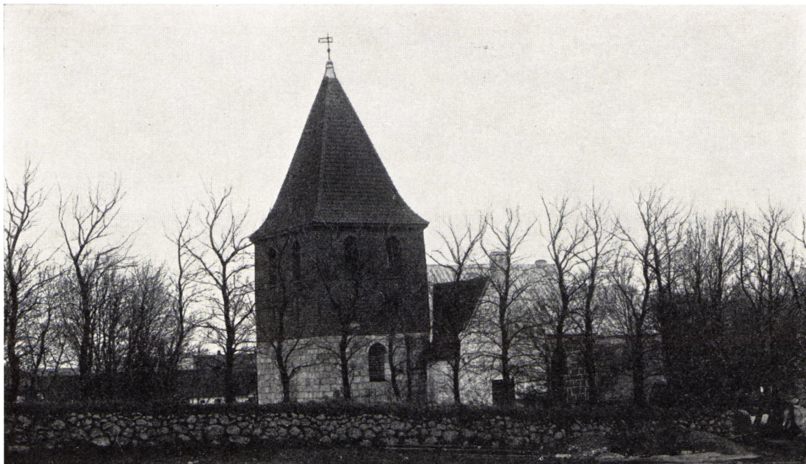
Kirken efter Restaureringen.
