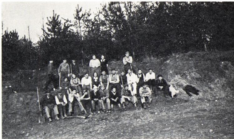
Et hvil under udgravningen af grusgraven i Kongebroskoven
