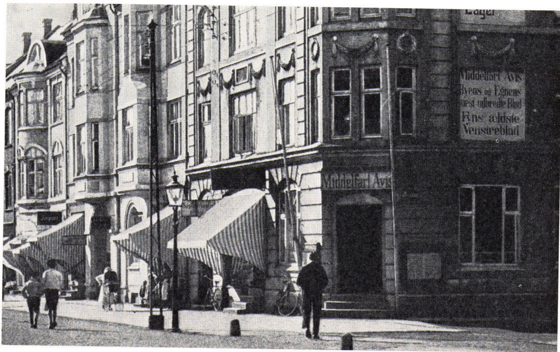
Middelbart Avis' flotte bygning i Østergade
