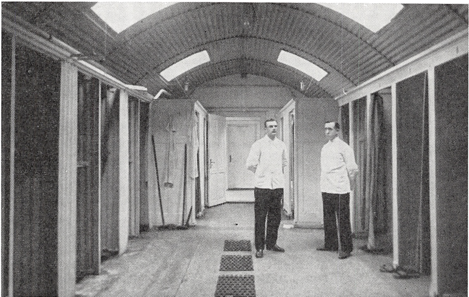
Interiør fra den kommunale badeanstalt, der lå bag belysningsvæsenets nuværende administrationsbygning – oprettet 1909.
