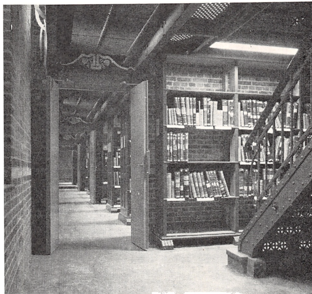
Stueetagen i Nyrops magasinbygning. Der er installeret automatisk virkende branddøre, varme og ny belysning. Iøvrigt står magasinet, som det afleveredes i 1893.
