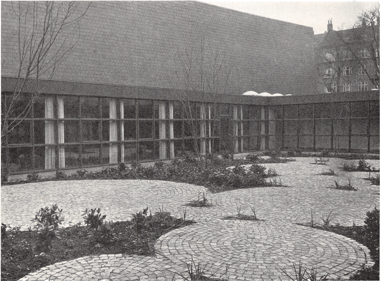
Den lange vinduesløse facade i det nye magasinhus, beklædt med sorte skifersten, ses i baggrunden. Foran har man den lave mellembygning i lette materialer og helt i forgrunden den beplantede gårdhave med det dekorative cirkelmotiv.
