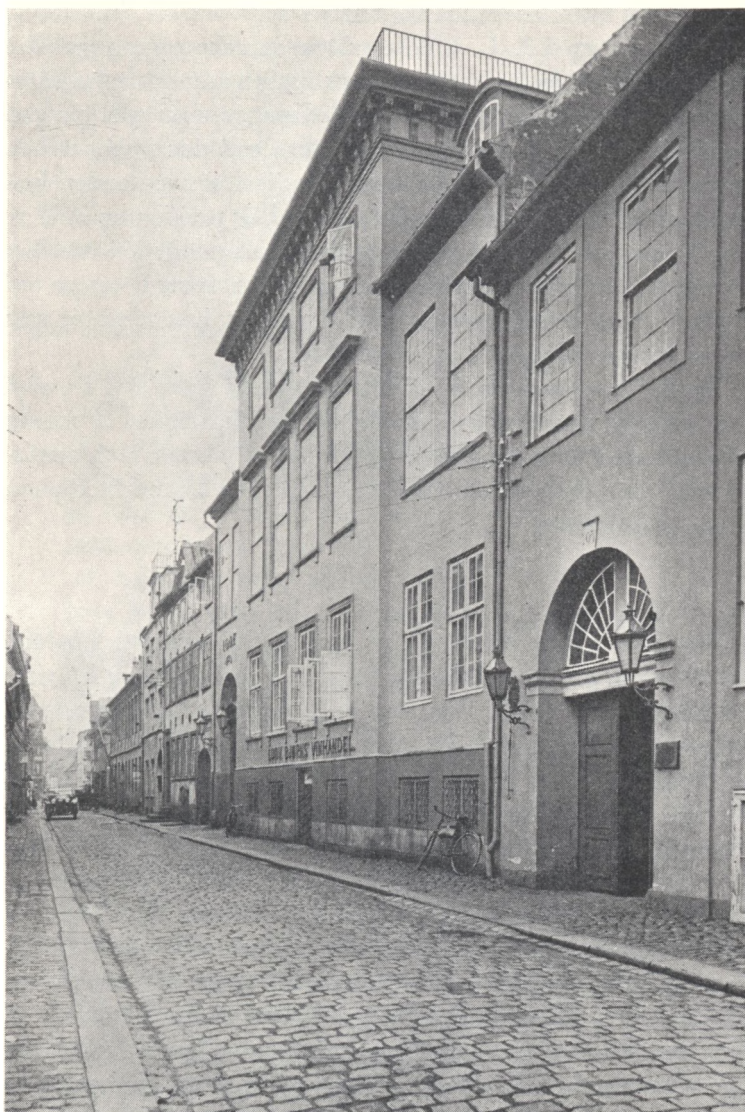
Fig. 7. Det Claessenske palæ, Strandgade 93, udført af C. F. Harsdorff i samarbejde med A. C. Wilcken.
