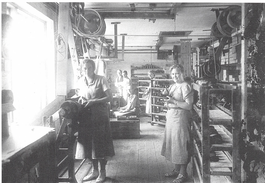
Interiør fra »Alsing« 1937. Bemærk remtrækkene til maskinerne. (Foto Holger Nielsen; Vallekilde.)
