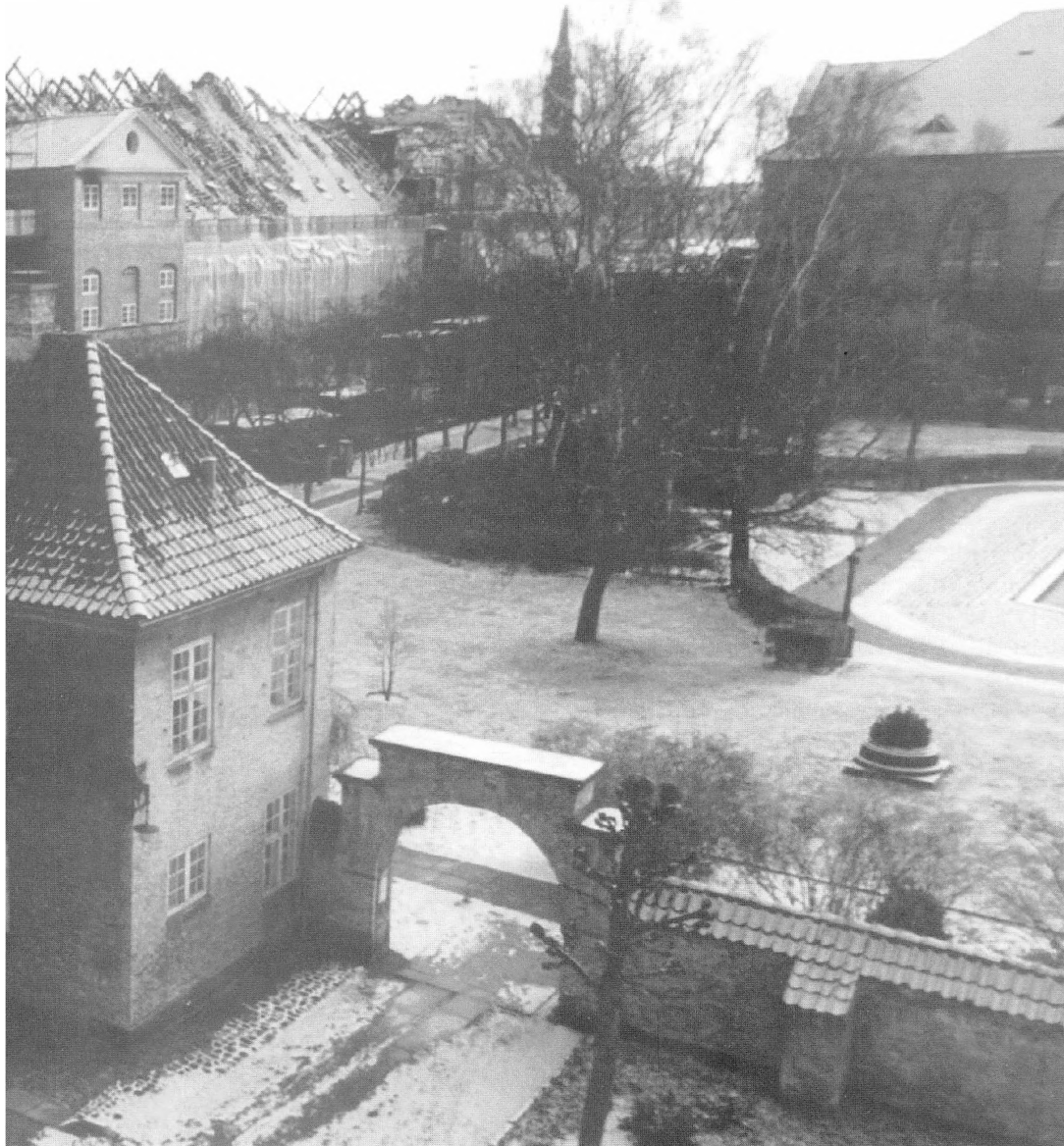
Provianthuset og bibliotekshaven efter branden. Billedet er taget fra Rigsarkivets hovedbygning ned mod en af Rigsarkivets pavilloner. Foto: Pirita Taskinen, Rigsarkivet
