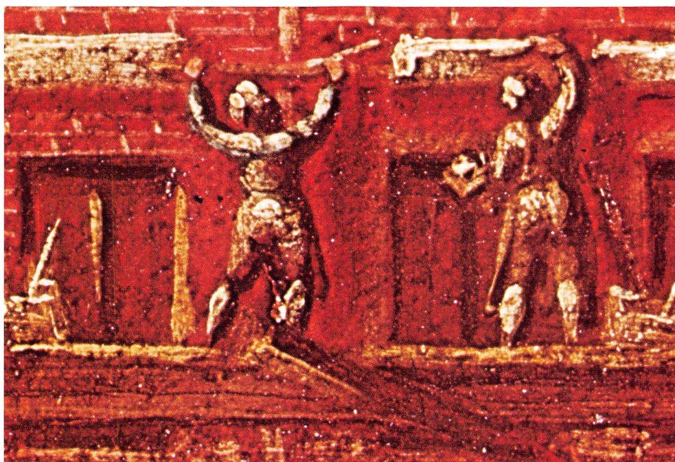
Murersvend trækker båndgesims. Mørtelen i kalkkasser af kurvefletning.
