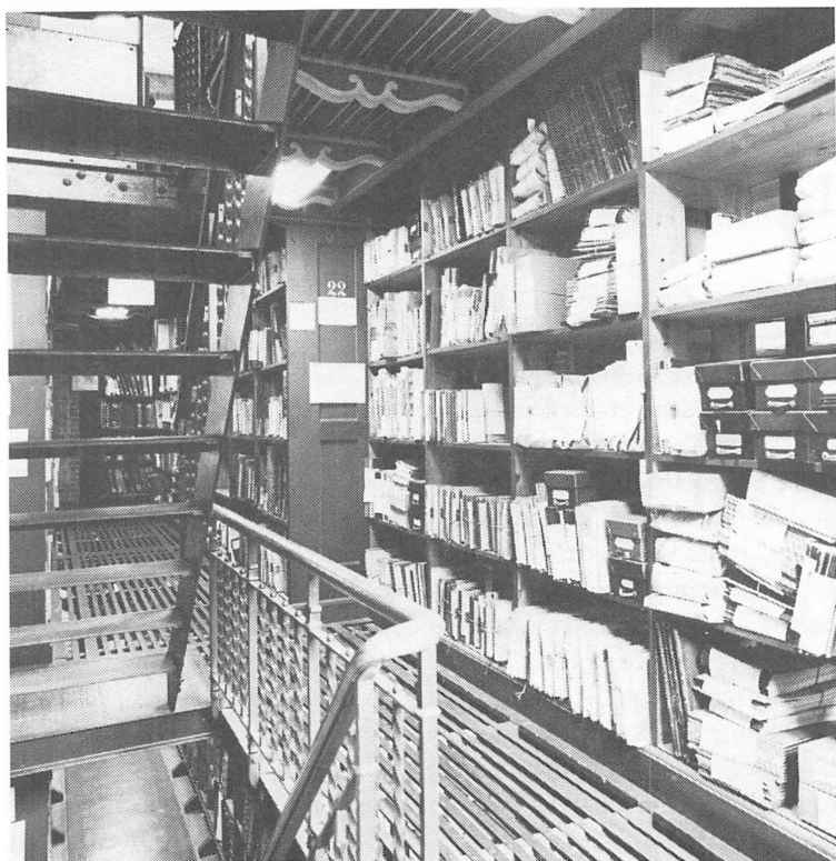
Københavns Stadsarkivs magasiner ligger i Københavns Rådhus fra 1892–1902. Med deres metalristegulve er de typiske eksempler på tidens arkivindretning. Det er også karakteristisk for tiden, at Martin Nyrop har villet sørge for ornamentik selv i så prosaiske rum som arkivmagasiner. Foto: Stadsarkivet.
