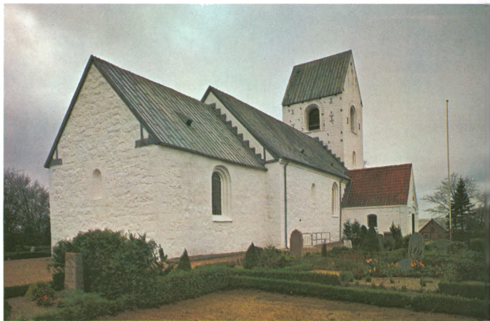
ESTVAD KIRKE set fra nordøst. Under det hvide kalklag lader murstrukturen sig ane. Man fornemmer den klævede kâmp i de buklede flader.
