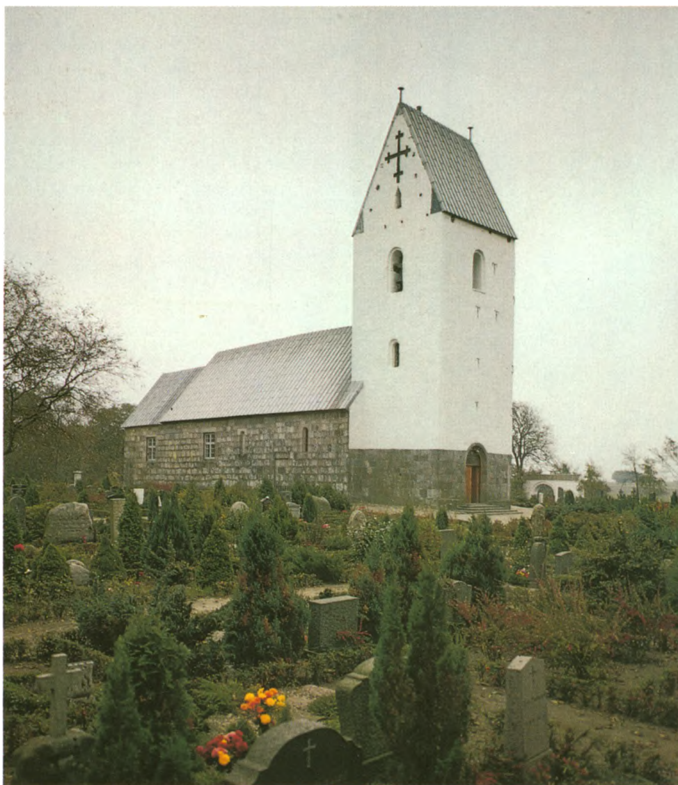
Den blytækte kvaderstenskirket set fra nordvest. Det sengotiske tårns øvre partier er af munkesten.
