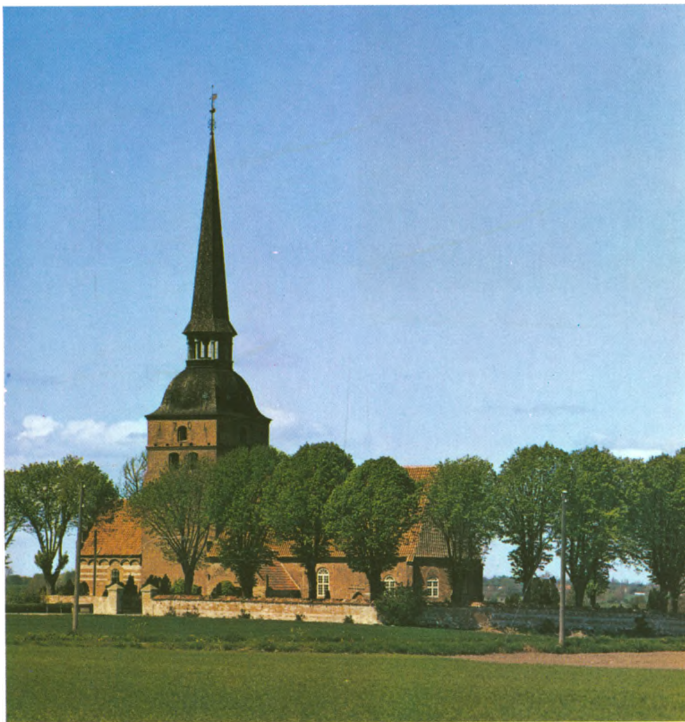
KIPPINGE KIRKE set fra sydøst med det vældige spir i barokstil og den ejendommelige korrunding med stræbepiller. Taget er den dag i dag tækket på middelalderlig manér med »munke og nonner«.
