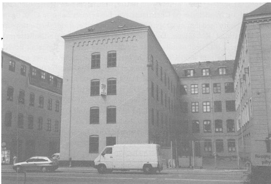
Fig. 8. Medens Christianshavns straffeanstalt blev revet ned 1928 for at give plads til bl.a. »lagkagehuset« blev Christianshavns arresthus ombygget til beboelse, kontorer og værksteder. I enkeltcellebygningen er der endog diskotek. Forbygningerne for fængselsgårdene med forbindelsesgange og porte er nedrevet og man ser hovedbygning, natcellebygning og enkeltcellebygning samt forbindelsesbygningen mellem de to første. På hovedbygningen er der dog kun en mindetavle for veterinærskolen 1773.
