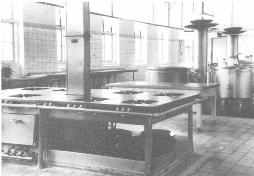
Fig. 37. Det ny køkken i arkitekt Barfoeds køkkenbygning. Køkkenet er senere ombygget.
