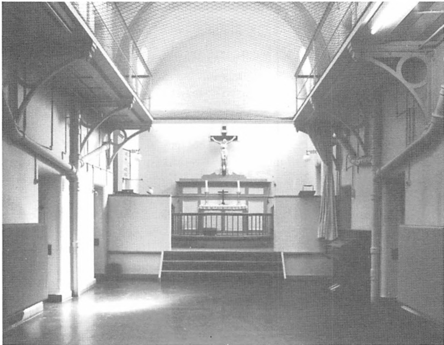
Fig. 41. Interieur fra Blegdamsvejens fængsel. I den østlige ende af den panoptiske korridor var der et kirkeparti. Det ses her efter en ombygning i 1956. Det er nu nedbrudt, da korridoren ikke længere kunne tjene som kirkerum.
